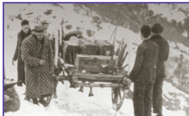
Neu, fred, per la serra, en condicions deplorables...
