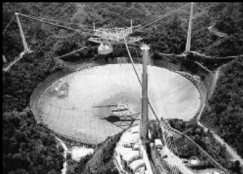
Vista aèria del radiotelescopi d'Arecibo, a Puerto Rico, el més gran del món i font de dades per al projecte SETI. L'antena fa tres-cents cinc metres de diàmetre.
