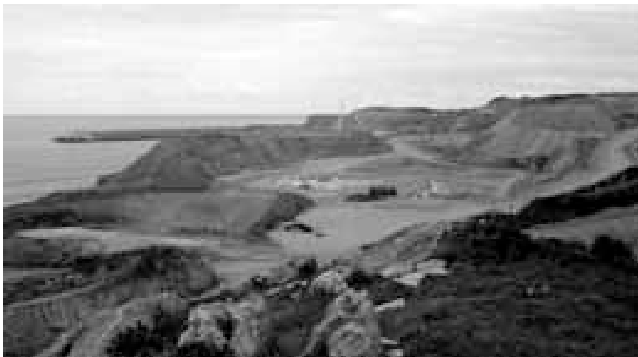
OBRAS DEL PUERTO EXTERIOR DE A CORUÑA
