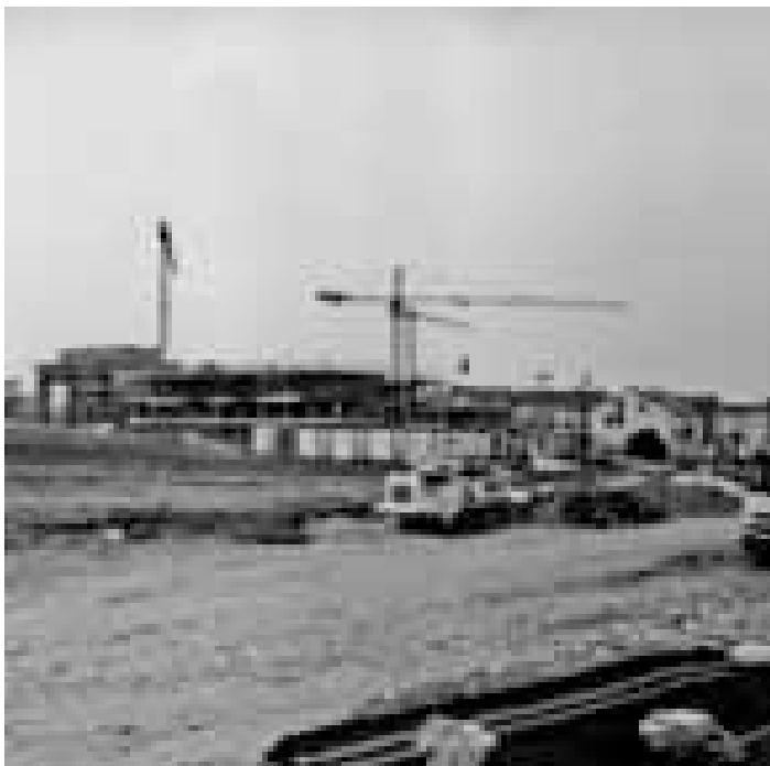
500 VIVIENDAS EN CONSTRUCCIÓN EN EL PARAJE COSTERO DE LA TALÁ, LLANES
